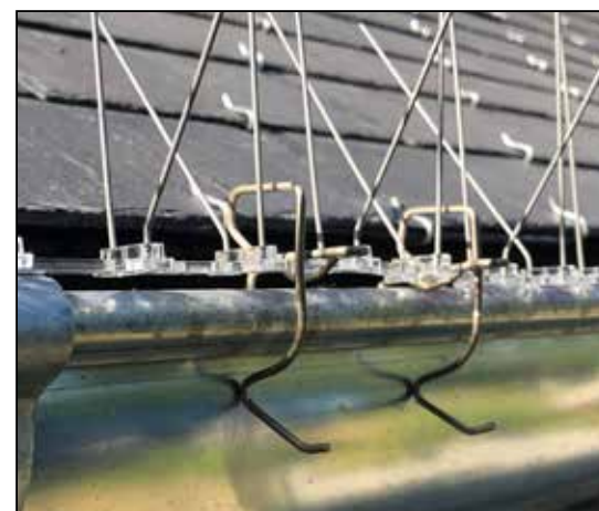
Clip inox sur semelle Easyspike
